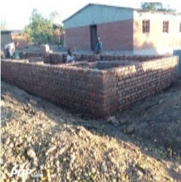
Bild 1 Neubau einer Mädchenherberge in der CHAMAKALA SECONDARY SCHOOL
